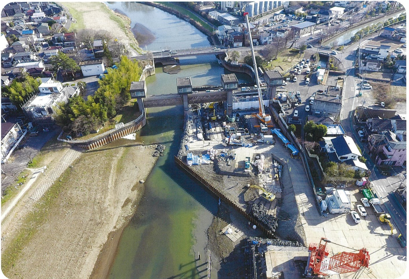
耐震改修工事中の古利根堰（越谷市大字大吉地内）
